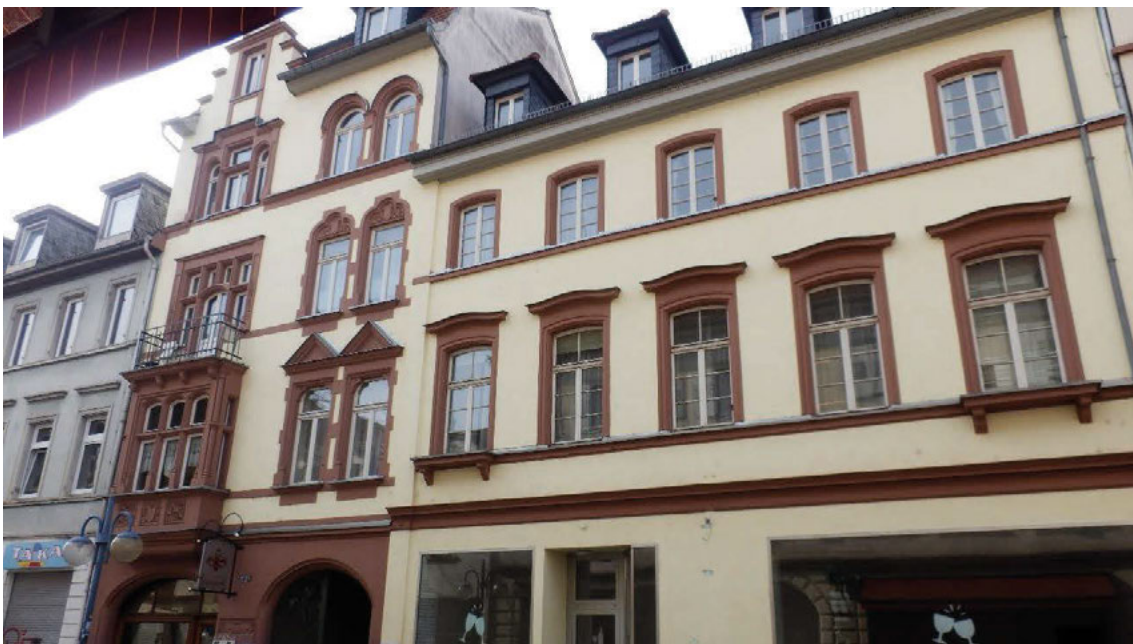
Abbildung 25: Restaurierter Altbestand, Nordostseite G7
