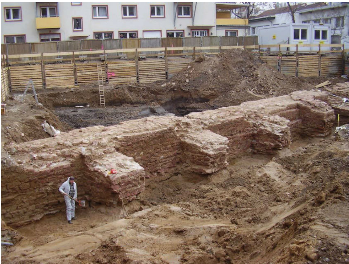
Abbildung 47: Fundamente der Befestigung bei den Bauarbeiten in R7 (Stadtentwässerung Mannheim, Pich, Dez. 2009)
