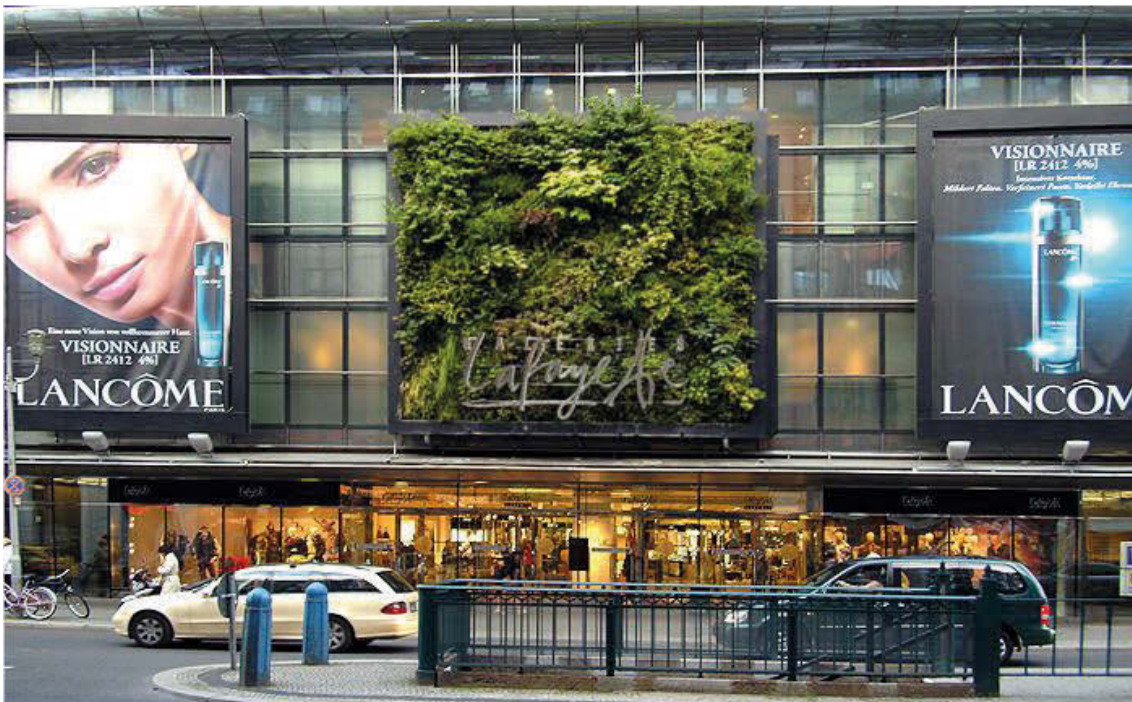
Abbildung 24: Grüne Wand an der Galeries Lafayette in Berlin, Spätsommer 2011 (Aufnahme: Thorwald Brandwein 2011, Quelle: http://www.biotekt.de/fassadenbegruenung )
