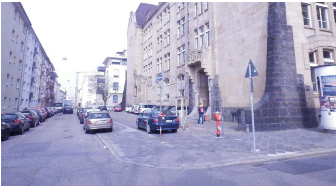
Abbildung 50: Südwestseite der Friedrich List Schule mit Parkplätzen (C6)
