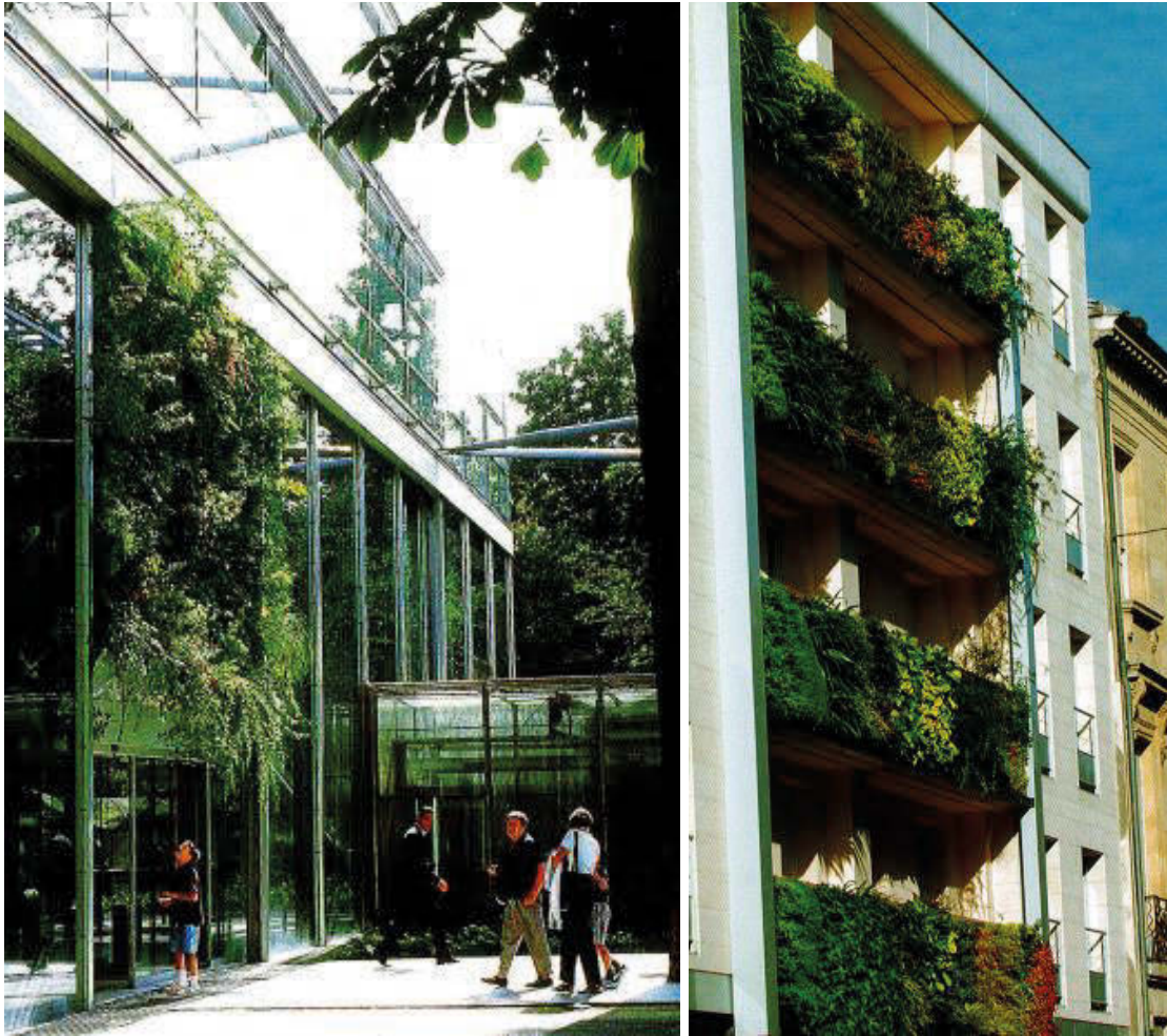
Abbildung 23: Durch eine grüne Wand betonter Eingangsbereich, links (Quelle Blanc 2009, S. 115); Begrünte Balkonfassaden, rechts (Quelle Blanc 2009, S. 158)
